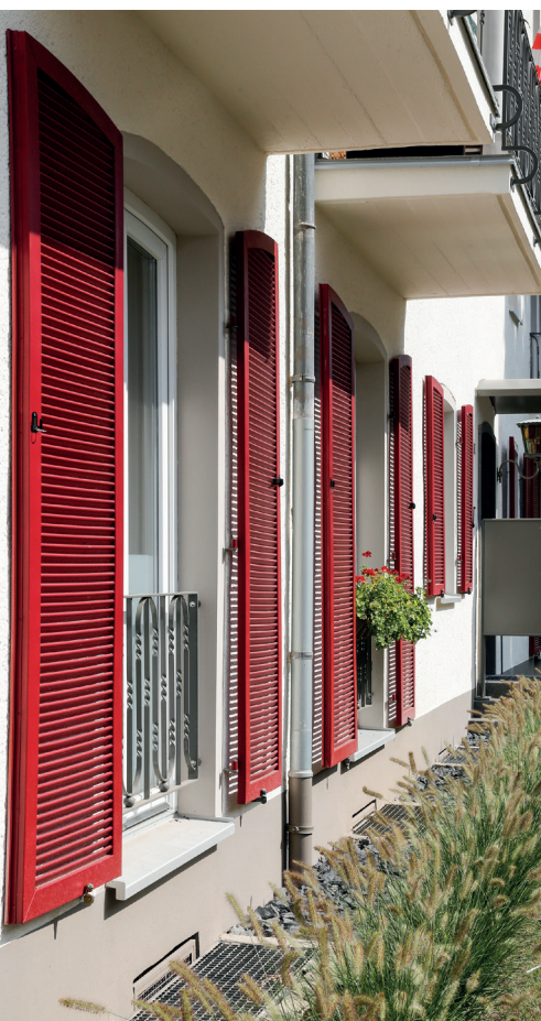
Bonn . Wesendonckstraße | Sanierung |
